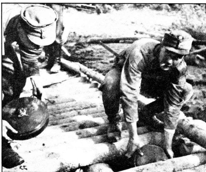
Soille oli rakennettu satoja kilometrejä telalavaa. Lähtiessä ne miinoitettiin
