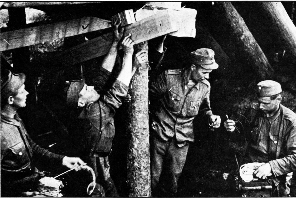
Silta on panostettu ja syytysjärjestelmä valmiina
