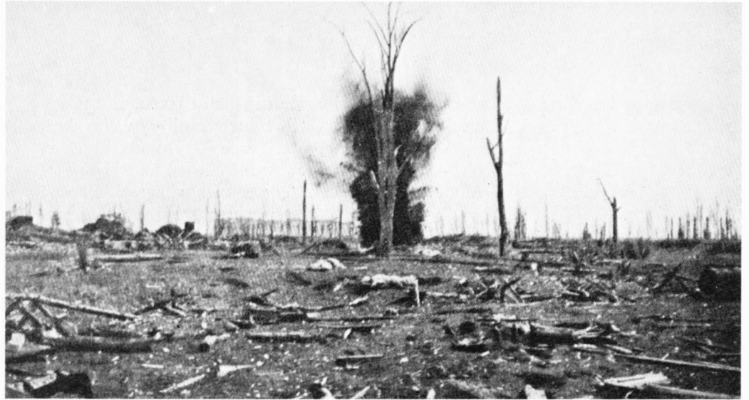
Tuli on tilapäisesti tauonnut 9.6.44 illalla. Takana näkyy Valkeasaaren asema
