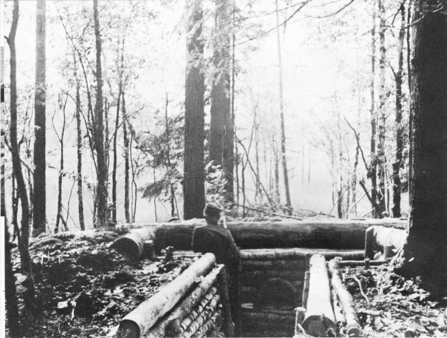
Rajajääkäripataljoona 4:n hirsinen pesäke suon reunalla Syvärin rintamalla
