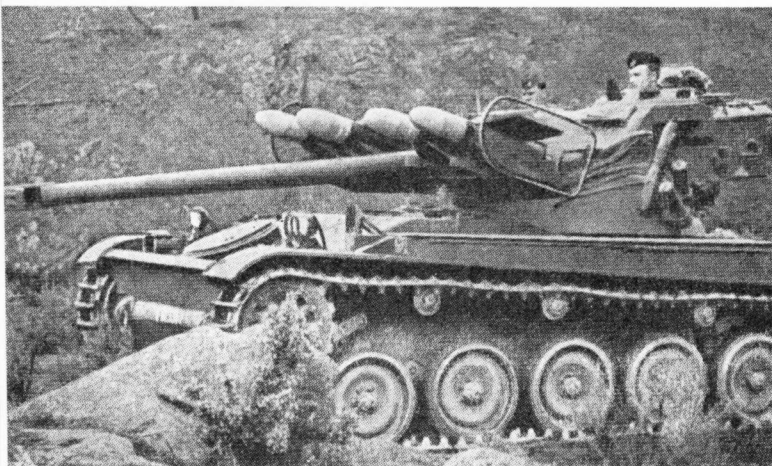
Ranskalainen ps-vaunu AMX, jossa 4 raskasta SS 11 pst-ohjusta. Ohjuksen kantama 3 km, paino 35 kg, läpäisee yli 50 sentin panssarin
