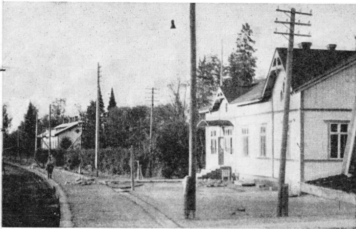
Karisalmen asema heti valtauksen jälkeen
