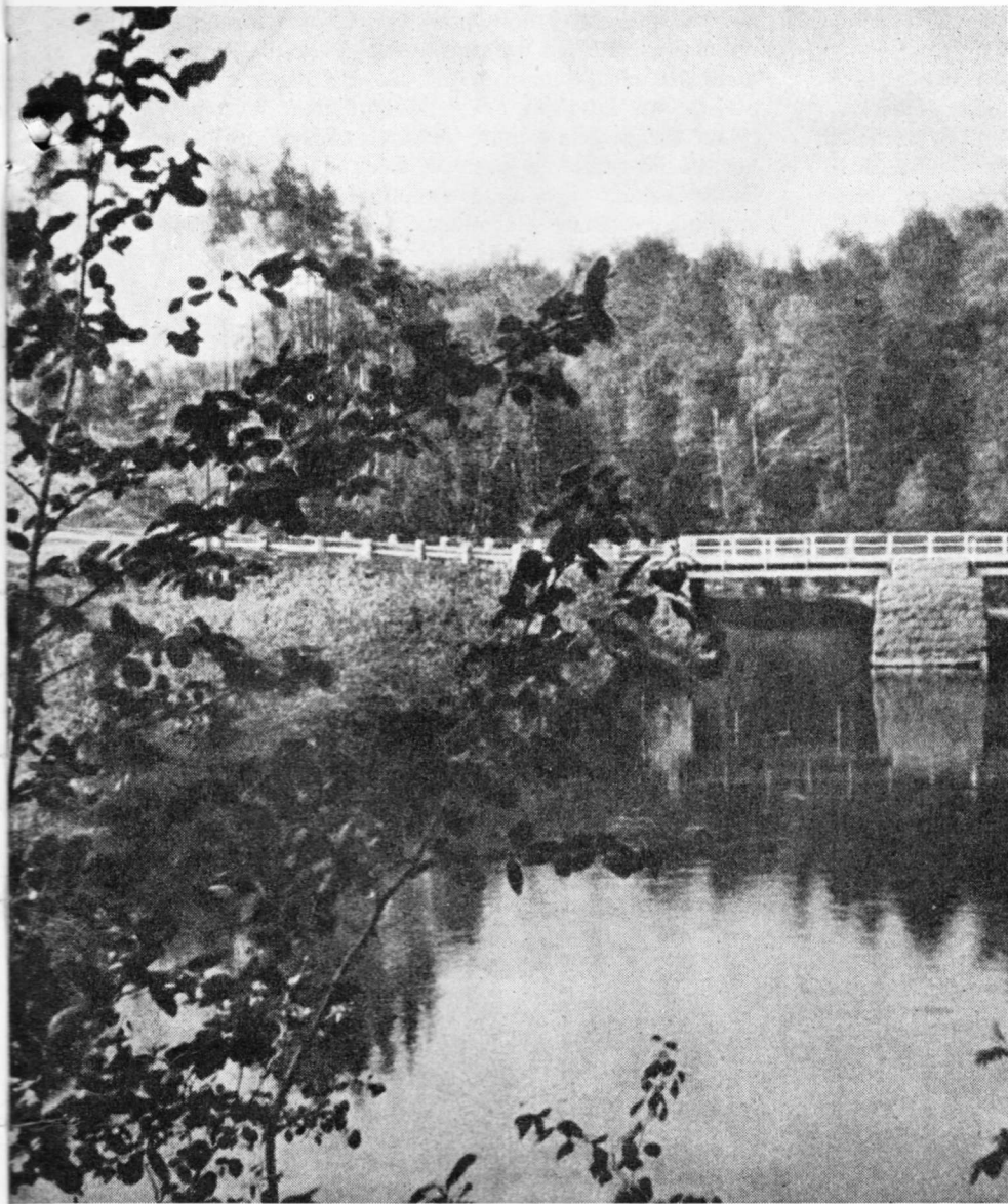
Vammeljoen suu ja silta
