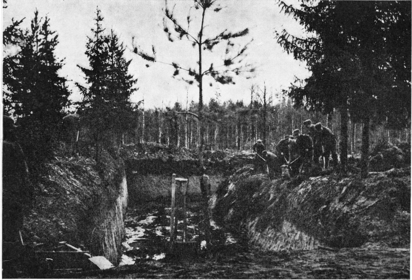
Maaemion suojaan rakenteilla oleva korsu
