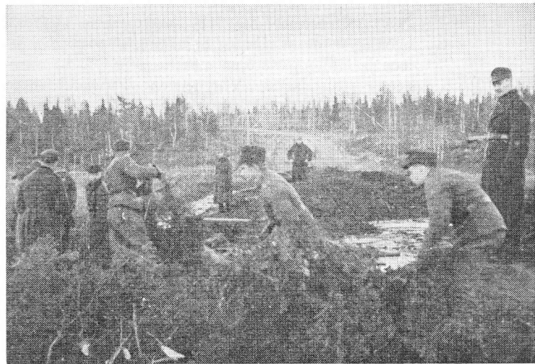
Lapin sodassa tuhottujen teiden korjaus käynnissä
