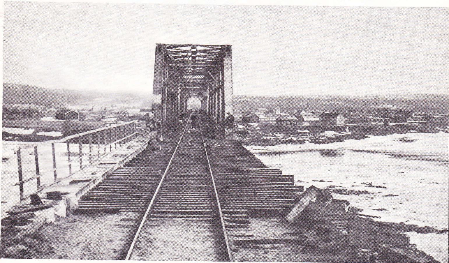
Entistään ehomaksi uudelleen rakennettu Suutarinkorvan silta
